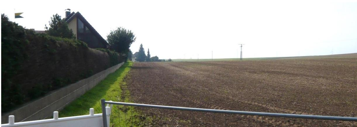
Abbildung 68: Errichtete Mauer zum Schutz vor Sturzfluten am Hotspot eins.
